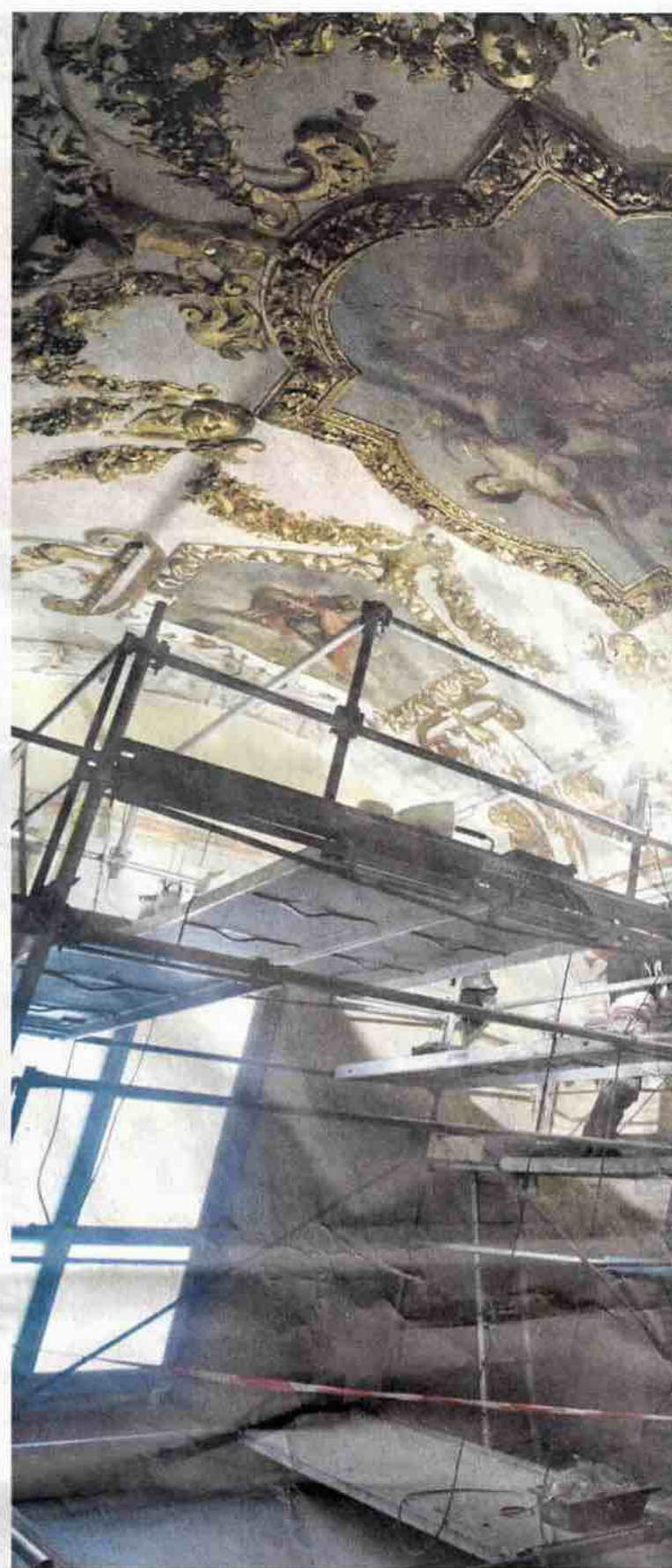
Des compagnons à l'œuvre sur leurs échafaudages font émerger des fresques et des dessins enfouis sous plusieurs couches de peinture de plomb.
