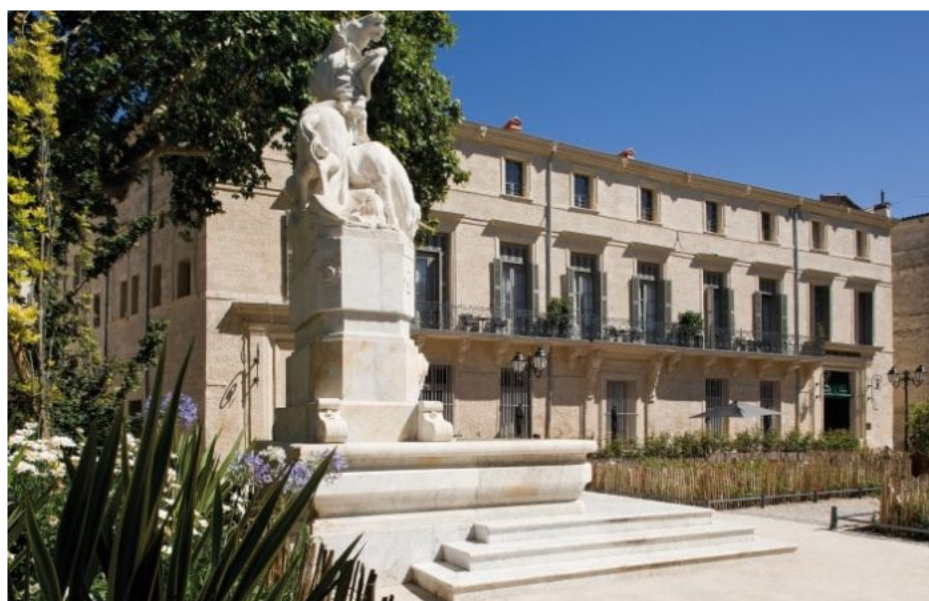
Pourcel Hôtel Richer de Belleval - façade @ agence sweep jerome mondiere
